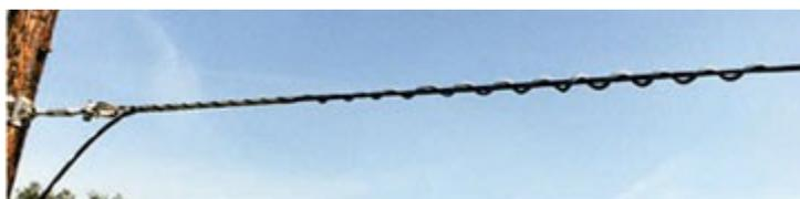
3. Если длина пролёта предполагает увеличение количества спиралей на пролет до 4 или 6, то производится монтаж дополнительных спиральных виброгасителей. Монтаж второй и третьей спирали производится от конца с меньшим диаметром витков как показано на рисунке:
